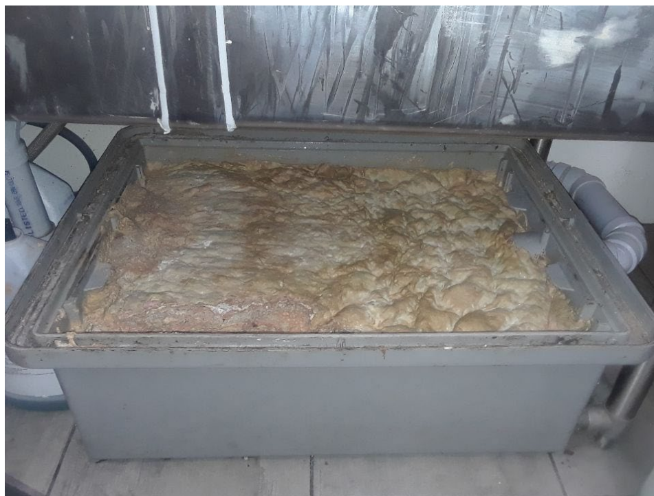
Exemple d'une trappe à graisse due pour une vidange
