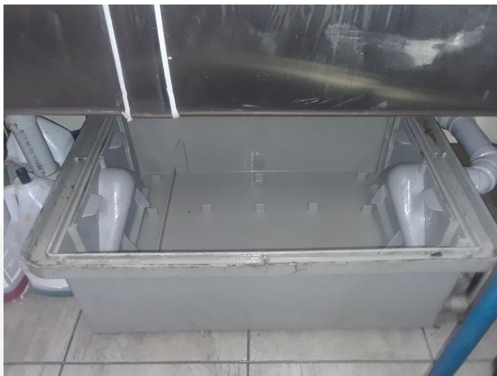
Exemple d'une trappe à graisse après la vidange
